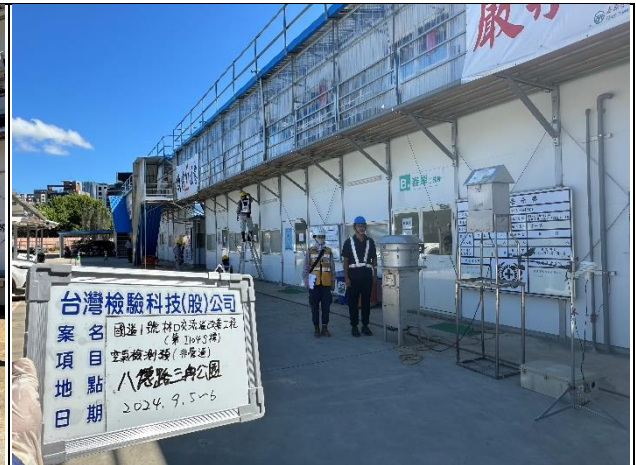
監測項目：空氣品質 監測日期：2024.09.05~06 監測地點：八德路三角公園
